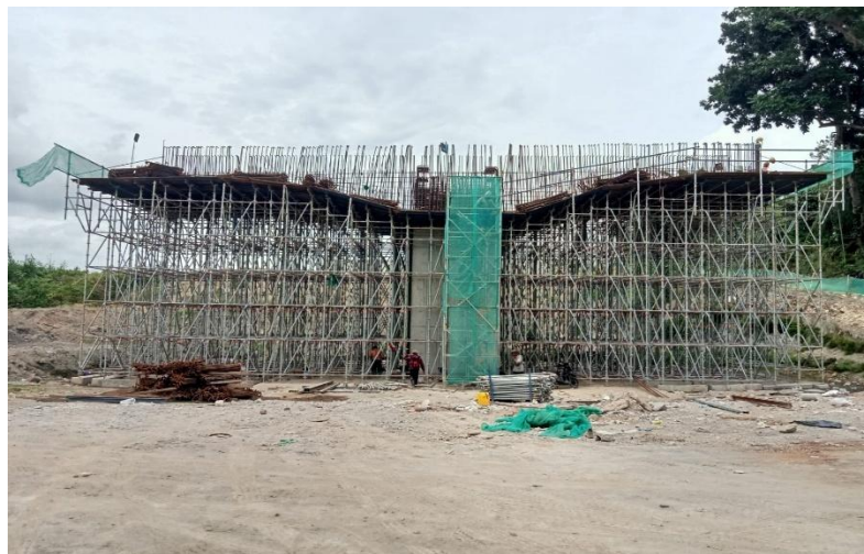
Gambar 1.2 Proses Pembangunan Pierhead Pada Proyek Pembangunan Jalan Tol Yogyakarta -Solo Seksi II B
