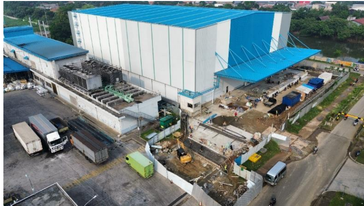
Gambar 1.1 Proyek Pembangunan Gudang PT Supernova Flexible Packaging
