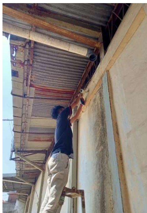
CCTV area proyek pembangunan
