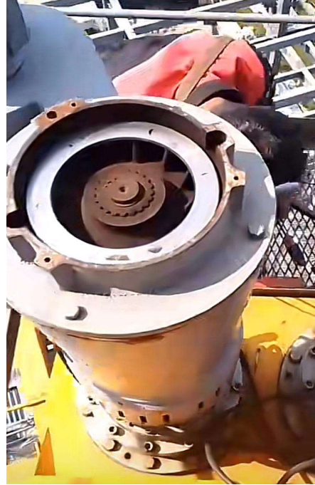
Pengecekan Kampas motor slewing
