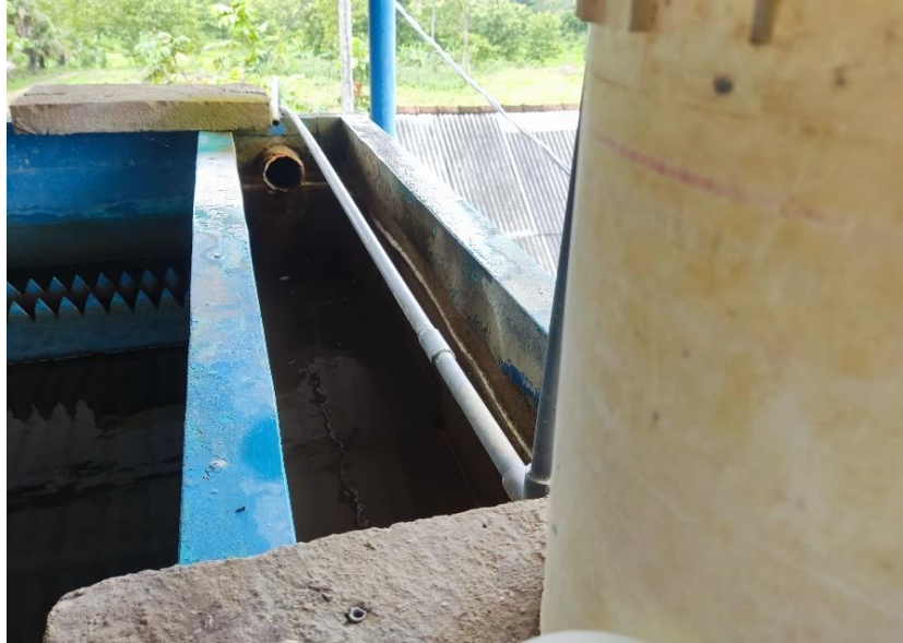
Gambar 4. 3 Bak Koagulasi & Flokulasi
