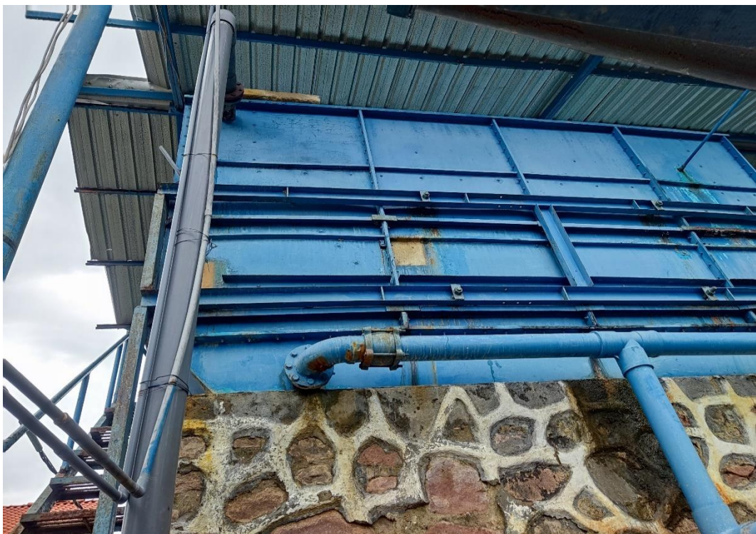
Gambar Bak Sedimentasi dan Koagulasi-Flokulasi
