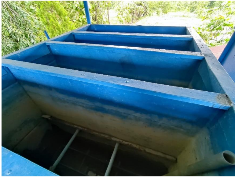
Gambar 4. 5 Bak Filtrasi & Desinfeksi
