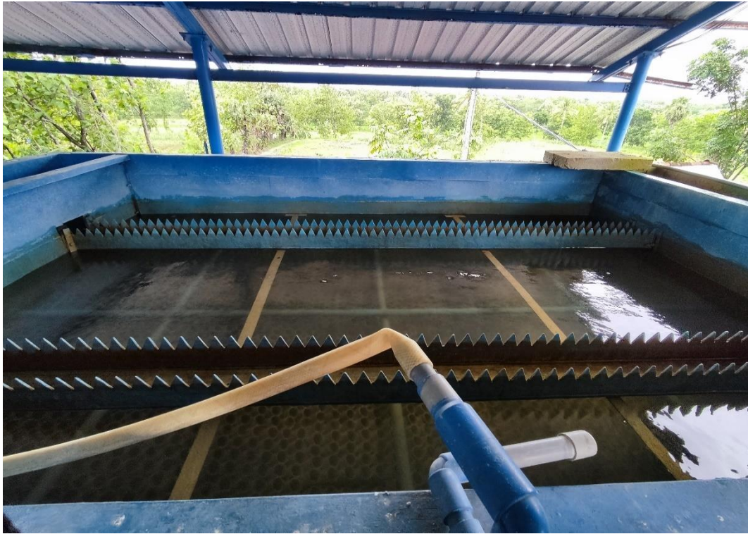
Gambar Bak Sedimentasi
