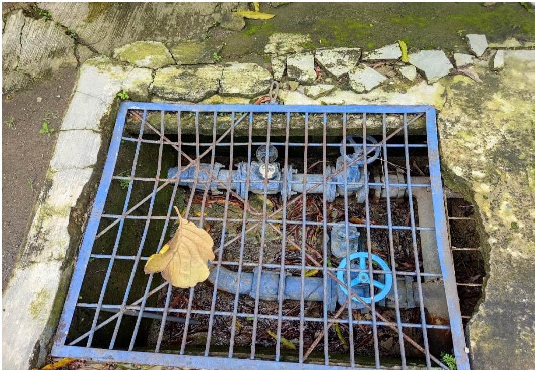
Gambar Pipa Jaringan Distribusi
