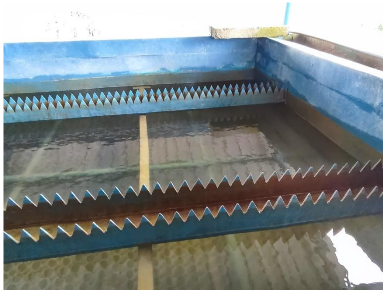
Gambar 4. 4 Bak Sedimentasi
