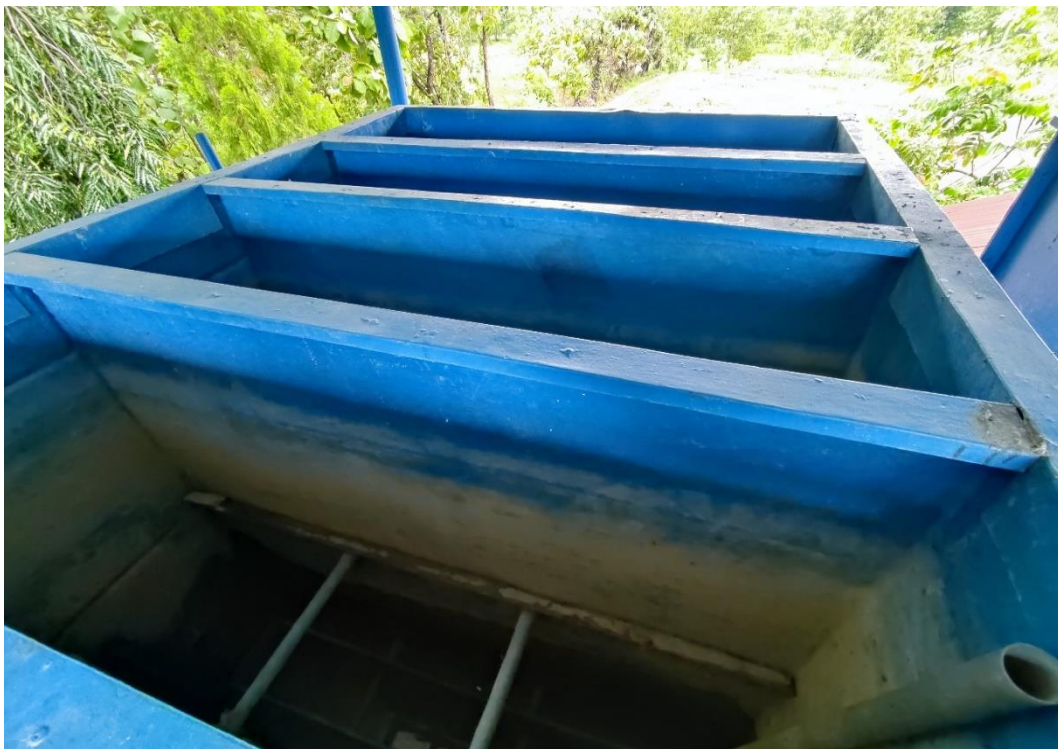
Gambar Unit Filtrasi dan Desinfeksi
