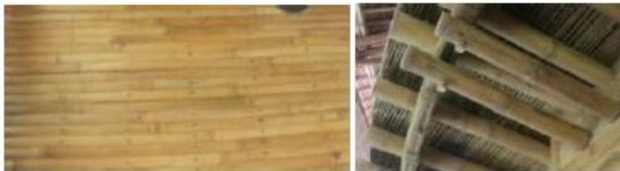
Gambar 2.18 Lantai Bambu & Konstruksi Penyangga
