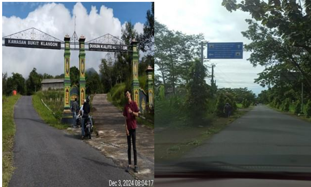
Gambar L-1.1 Survei Jalan Evakuasi
