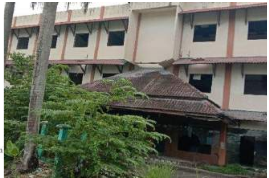
Gambar 1.2 Kondisi Hotel Bumi Nusantara Sumber foto : Google
