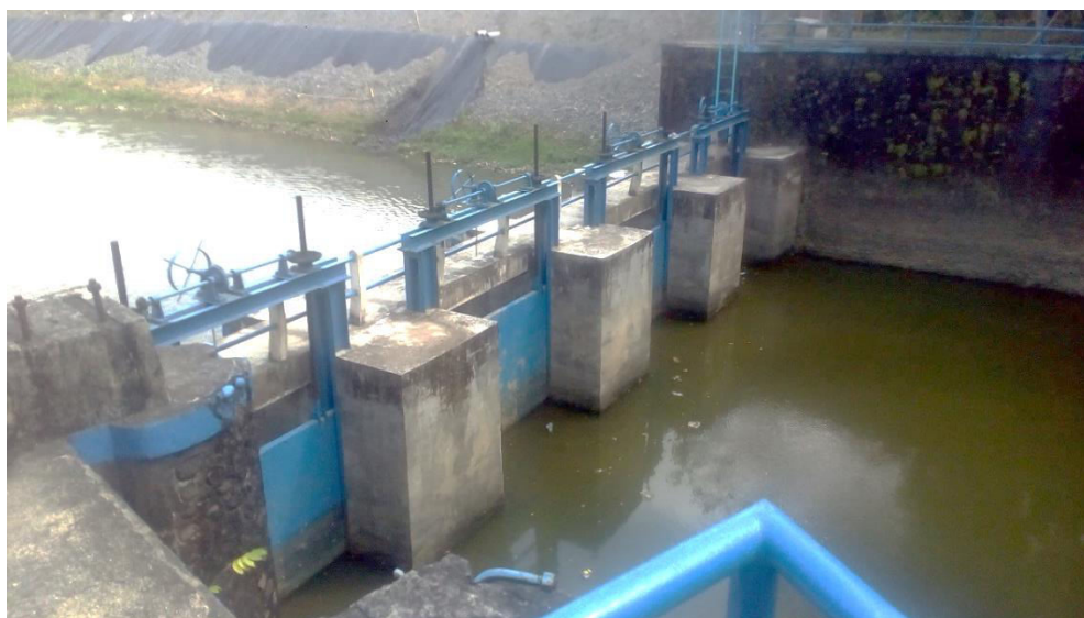
Gambar 1.1 Pintu Air Intake Kamijoro (Sumber : Dokumentasi 20-07-2017)
