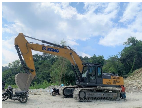
Gambar 5. 10 Excavator Berhenti Karena Adanya Pengarahan (Sumber : Dokumentasi Pribadi)
