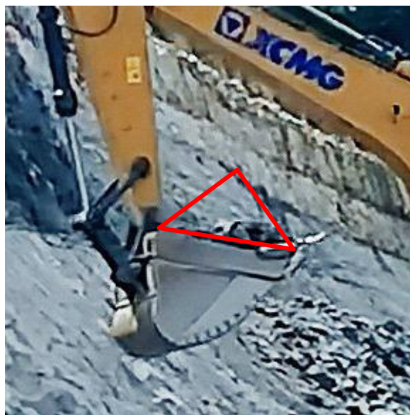
Gambar 5. 12 Bucket Excavator Memuat Material 75% (Sumber : Dokumentasi Pribadi)
