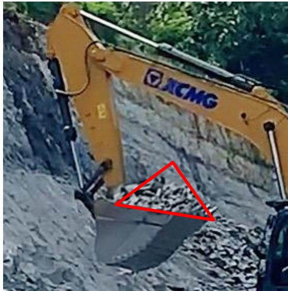
Gambar 5. 11 Bucket Excavator Memuat Material 85% (Sumber : Dokumentasi Pribadi)
