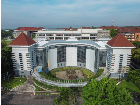
Gambar 1. Tampak depan atas Gedung Perpustakaan UII
