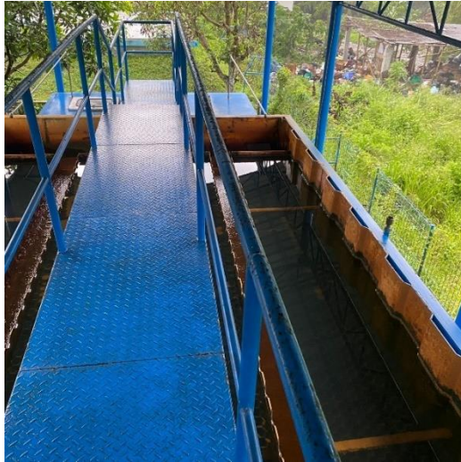
Gambar 4. 9 Instalasi Pengolahan Air PDAM Unit Depok
