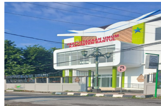
Gambar 2. Pembangunan perpustakaan umum bantul
