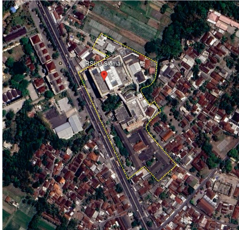
Gambar 4.3 Tampak Atas RSUD Sleman
