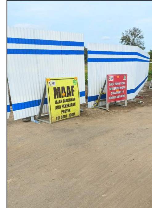
Rambu Pekerjaan Sementara
