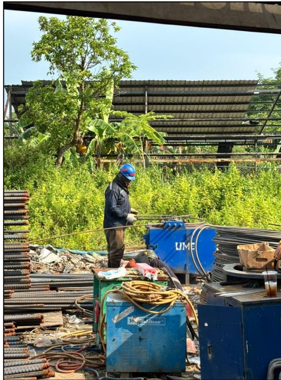
Pekerjaan Fabrikasi Tulangan
