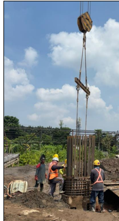
Pekerjaan Pemasangan Tulangan
