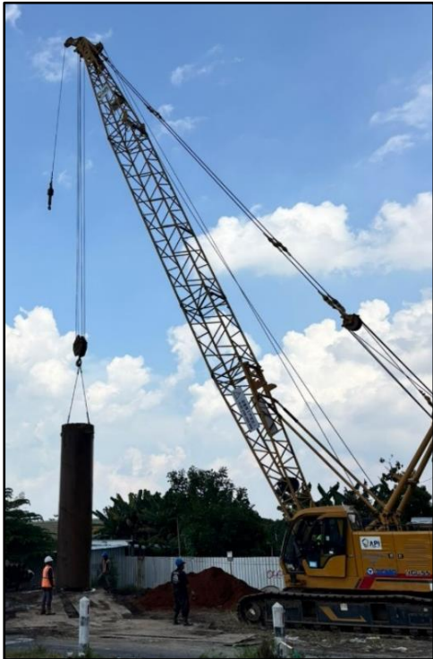
Pekerjaan Pemasangan Casing
