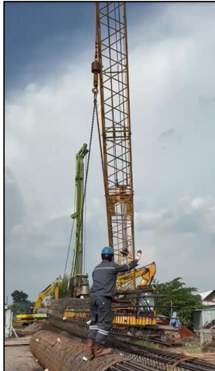
Pekerjaan Erection Tulangan
