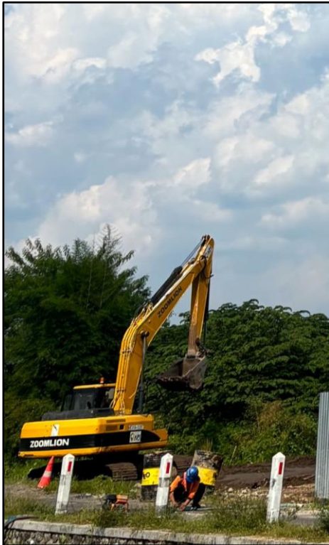
Pekerjaan Clearing Area
