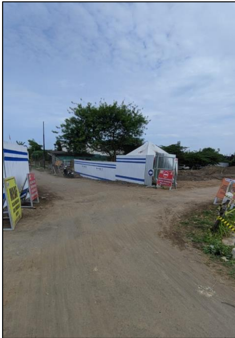
Pemasangan Rambu Di Persimpangan Akses
