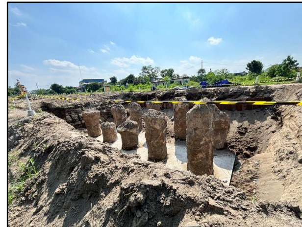
Safety Line Pada Area Bore Pile
