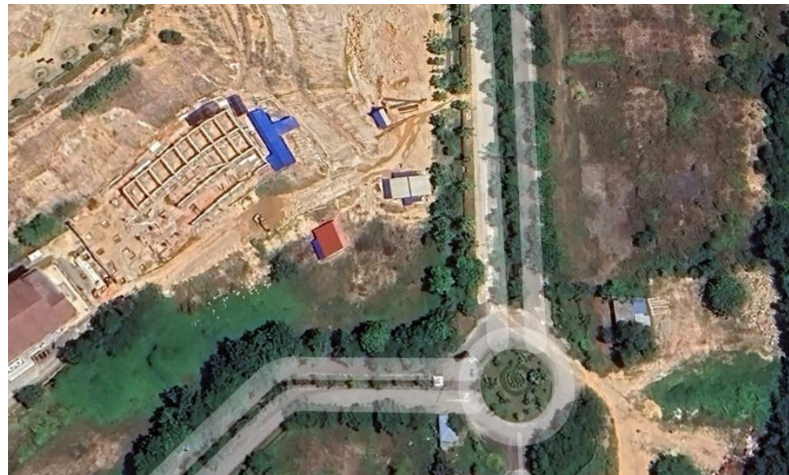
Gambar 4.1 Lokasi Proyek (Sumber: Google Earth 2024)
