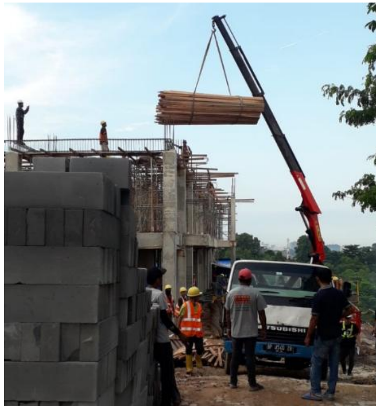
Gambar 5.19 Pekerjaan Mobilisasi Material ke Lokasi Pekerjaan
