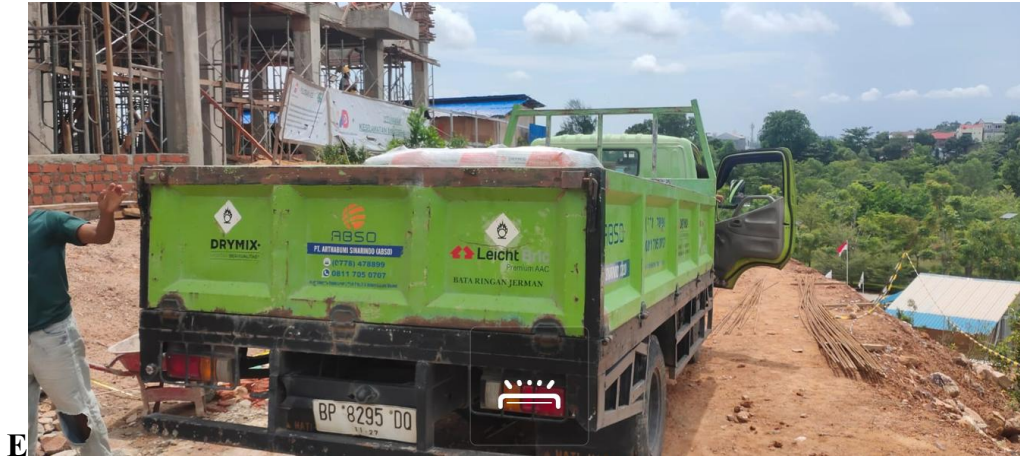
Lampiran L-1.1 Mobil Pengangkut Material Memasuki Lokasi Proyek
