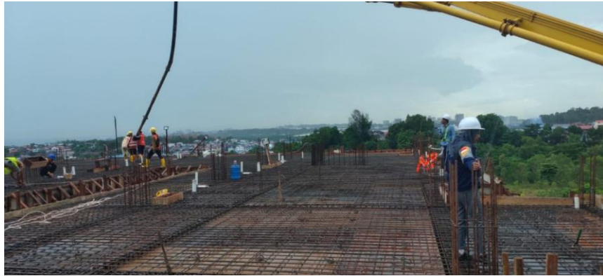
Gambar 4.4 Pekerjaan Pengecoran Balok dan Pelat Lantai
