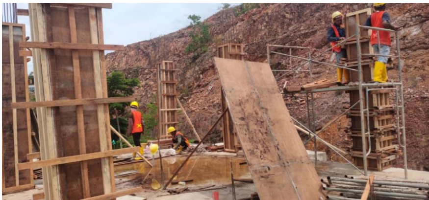
Gambar 4.5 Pekerjaan Pemasangan Bekisting
