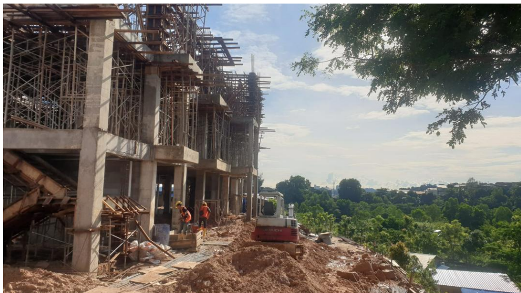
Gambar 5.16 Pekerjaan Penimbunan Tanah pada Jalur Mobilisasi
