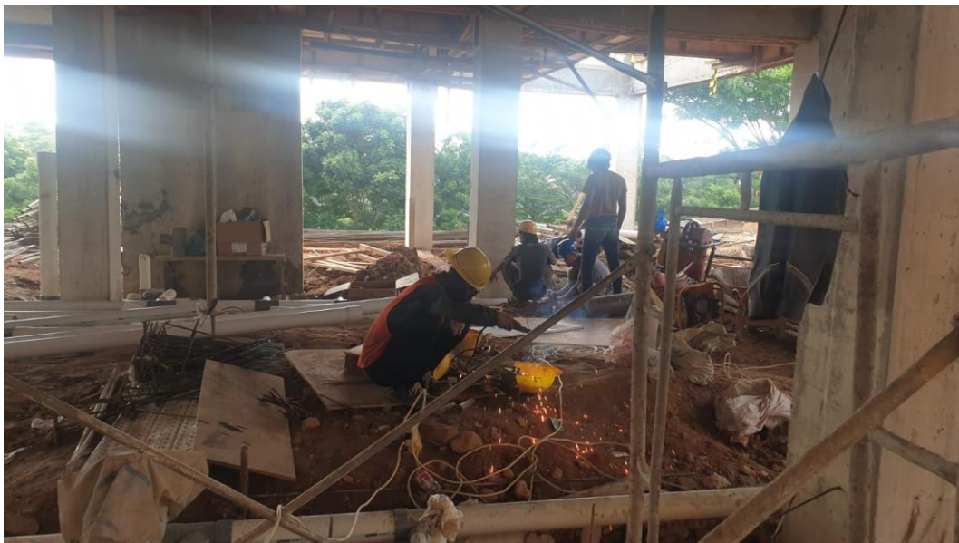
Lampiran L-4.2 Pemotongan Pembesian dengan Metode Pengelasan
