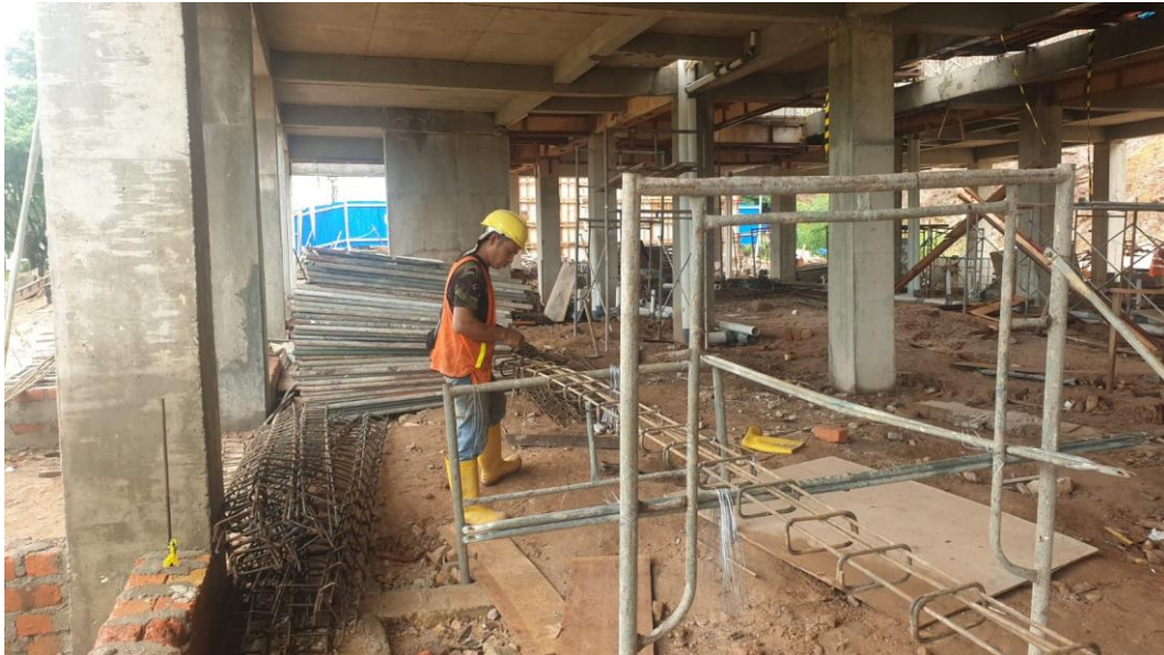
Lampiran L-4.1 Pembuatan Pembesian Secara Manual
