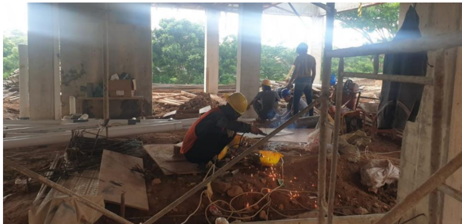
Gambar 5.20 Pekerjaan Pembuatan Pembesian Saat Pengelasan
