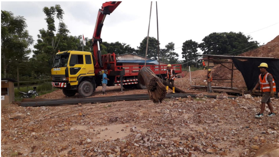
Lampiran L-1.5 Pengangkutan Material Besi ke Lokasi Proyek
