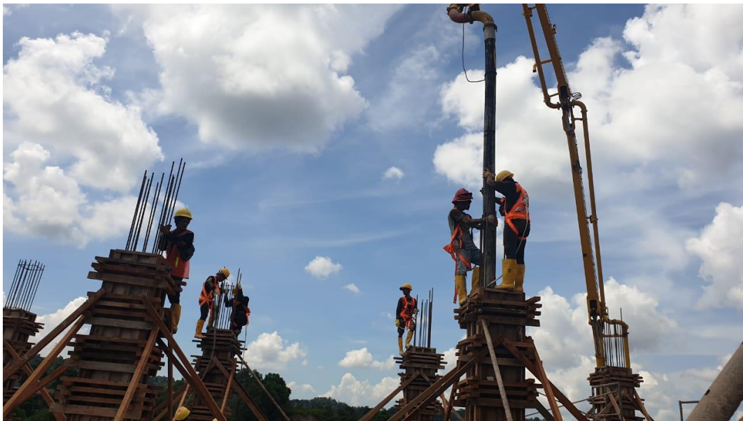
Lampiran L-8.3 Pengecoran Kolom
