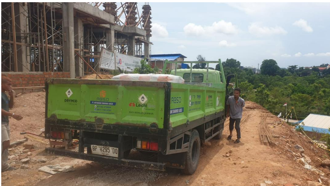
Gambar 5.18 Pekerjaan Mobilisasi Material ke Lokasi Proyek
