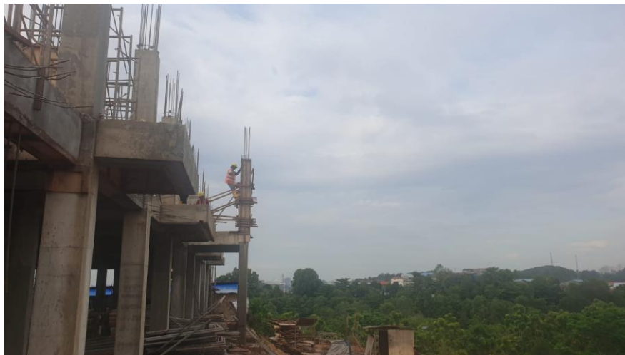
Gambar 5.26 Pekerjaan Pemasangan Bekisting Kolom
