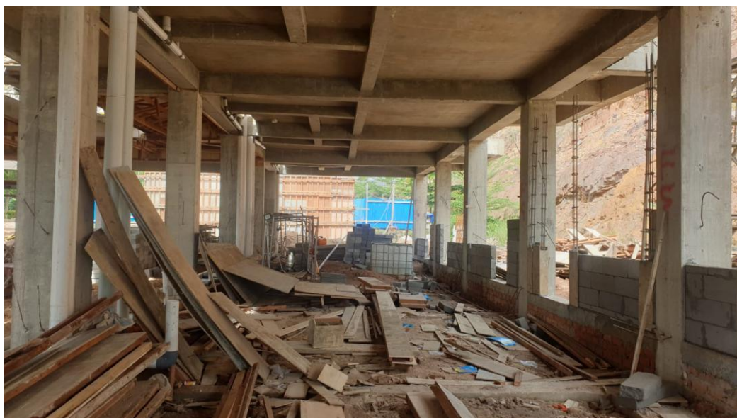
Lampiran L-3.2 Lokasi Pembuatan Bekisting Kolom
