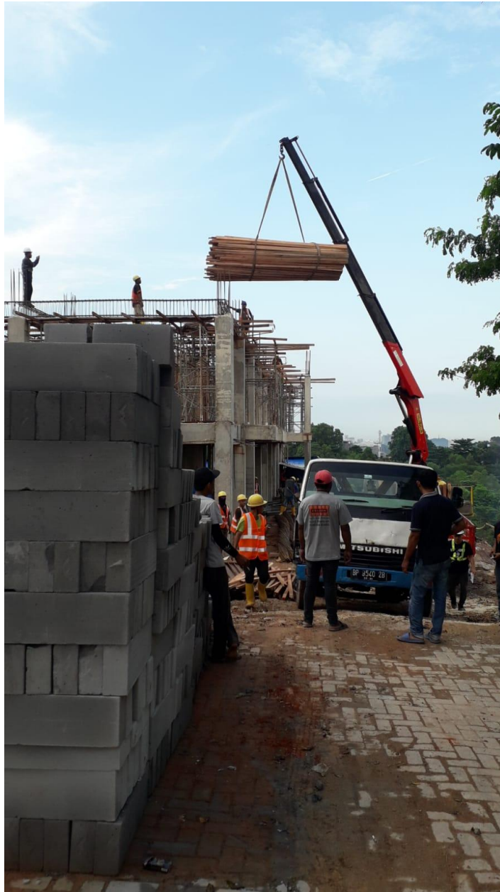
Lampiran L-2.1 Pengangkutan Material Kayu ke Lantai Atas
