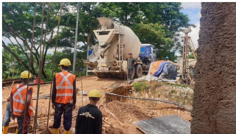
Gambar 5.28 Mobilisasi Truk Molen ke Lokasi Proyek
