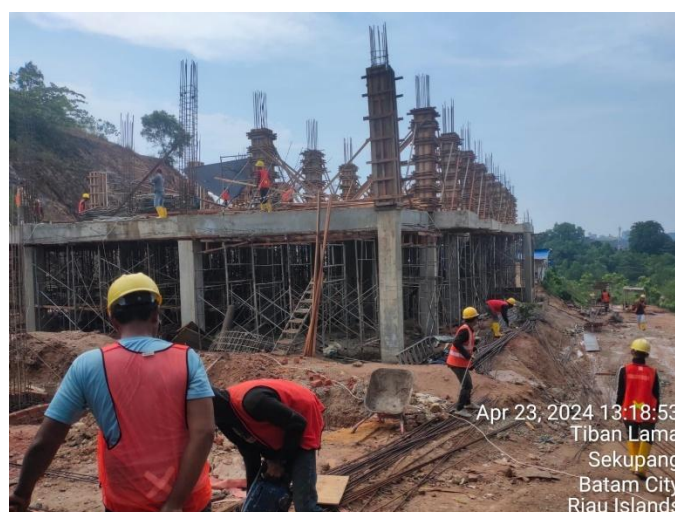
Lampiran L-2.3 Pengangkutan Material Besi
