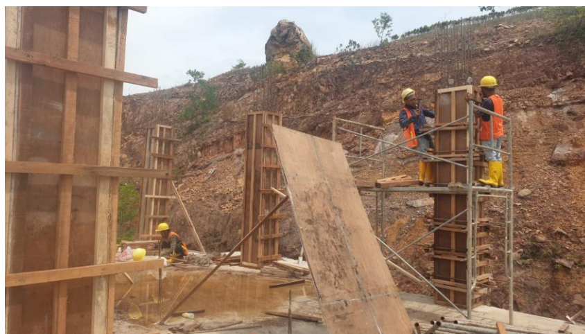
Lampiran L-6.2 Pemasangan Bekisting Kolom
