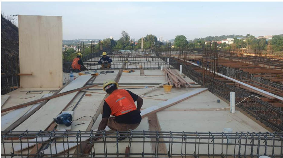
Gambar 5.21 Pekerjaan Pemotongan Bekisting
