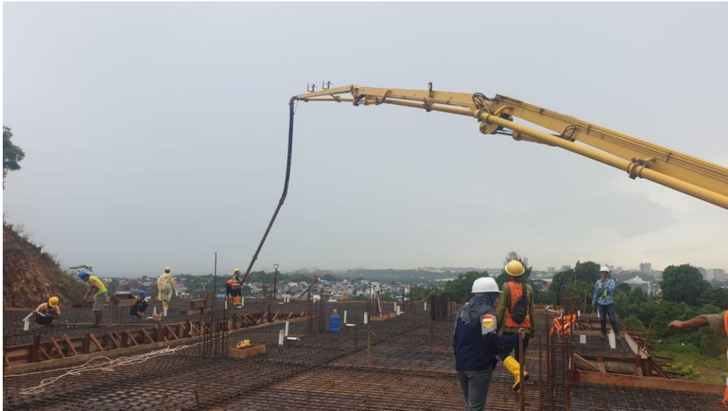
Lampiran L-8.5 Pengecoran Balok dan Pelat Lantai
