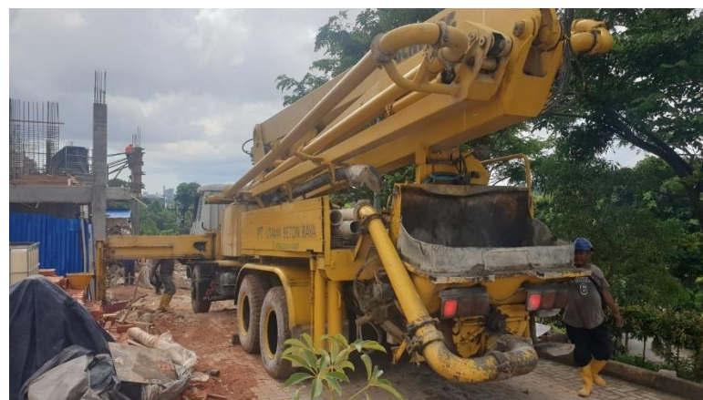
Gambar 5.29 Mobilisasi Pump Concrete ke Lokasi Proyek
