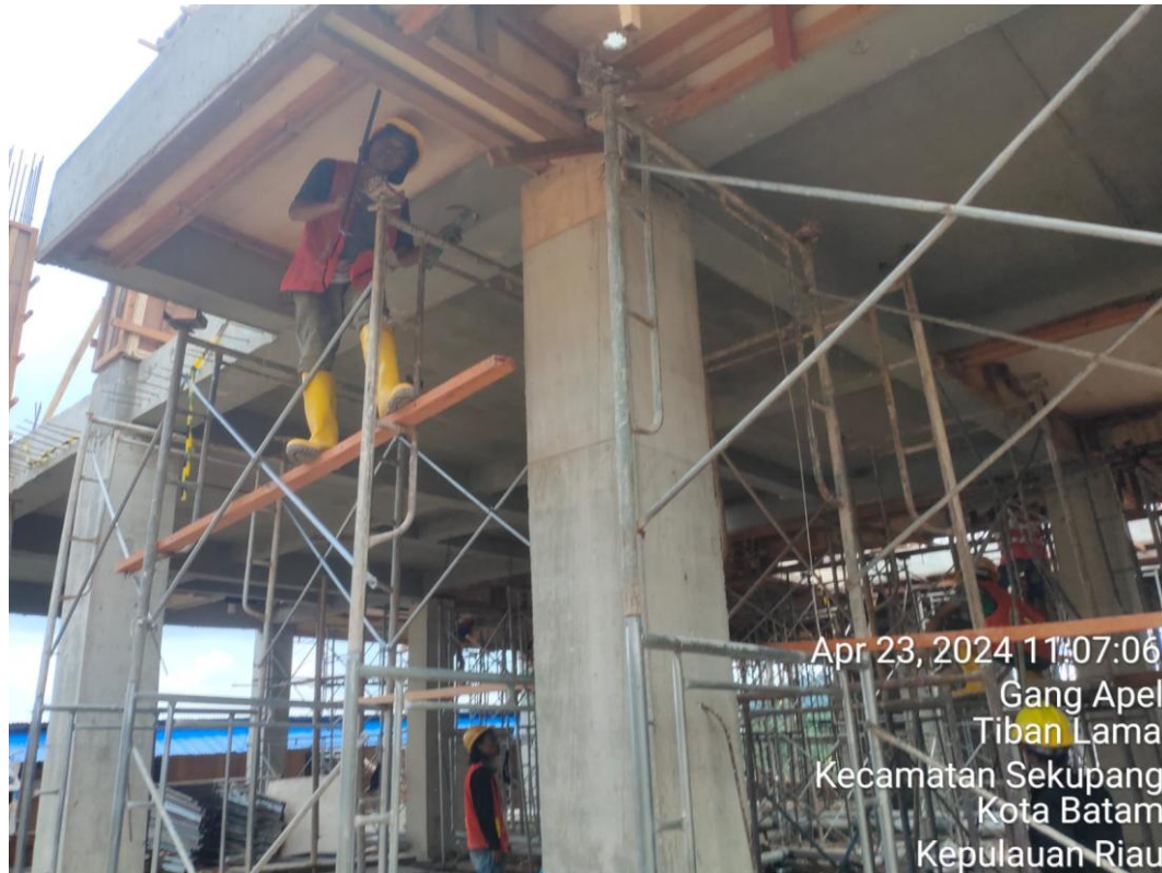
Lampiran L-9.1 Pelepasan Bekisting Balok dan Pelat Lantai
