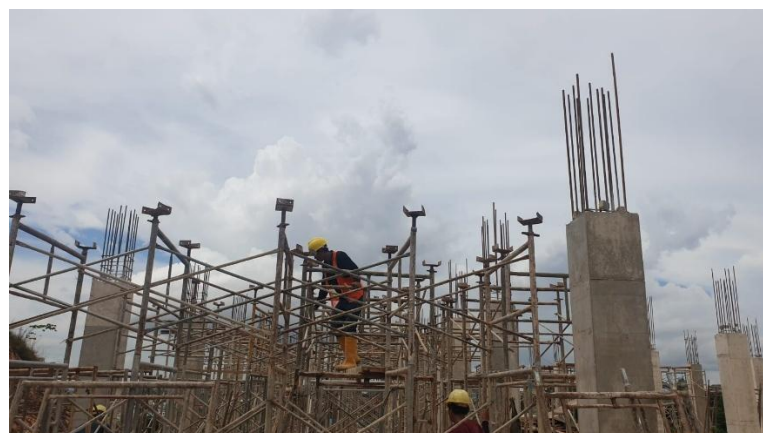
Gambar 5.23 Pekerjaan Pemasangan Scaffolding
