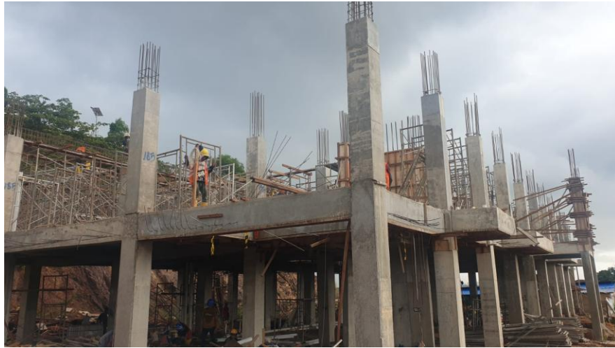
Gambar 5.24 Pekerja Mengangkat Scaffolding Sendiri
