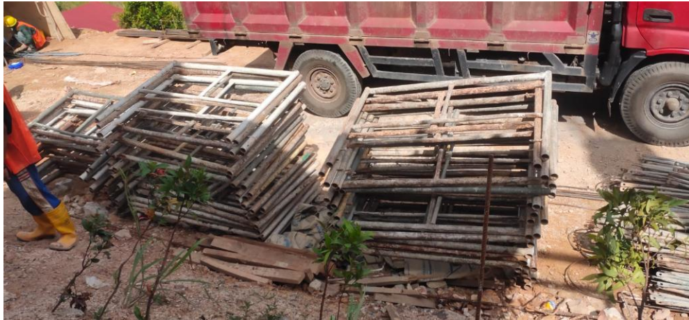
Lampiran L-1.3 Pengangkutan Scaffolding ke Lokasi Proyek
