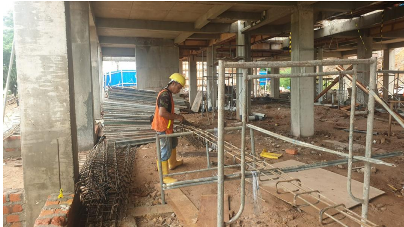
Gambar 5.22 Pekerjaan Pembuatan Pembesian
