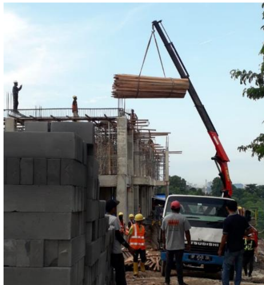
Gambar 4.3 Pekerjaan Mobilisasi Material ke Lokasi Pekerjaan
