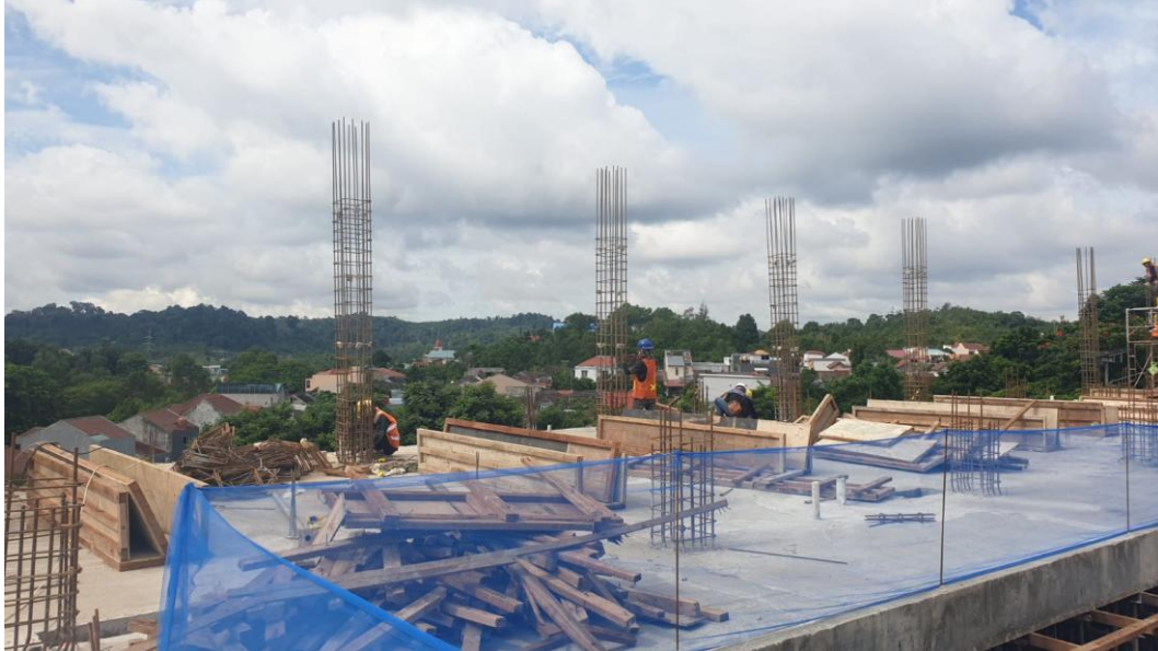
Lampiran L-7.1 Pemasangan Pembesian pada Kolom
