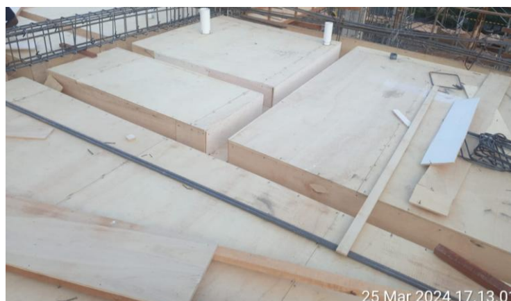
Lampiran L-6.3 Pemasangan Bekisting Pelat Lantai
