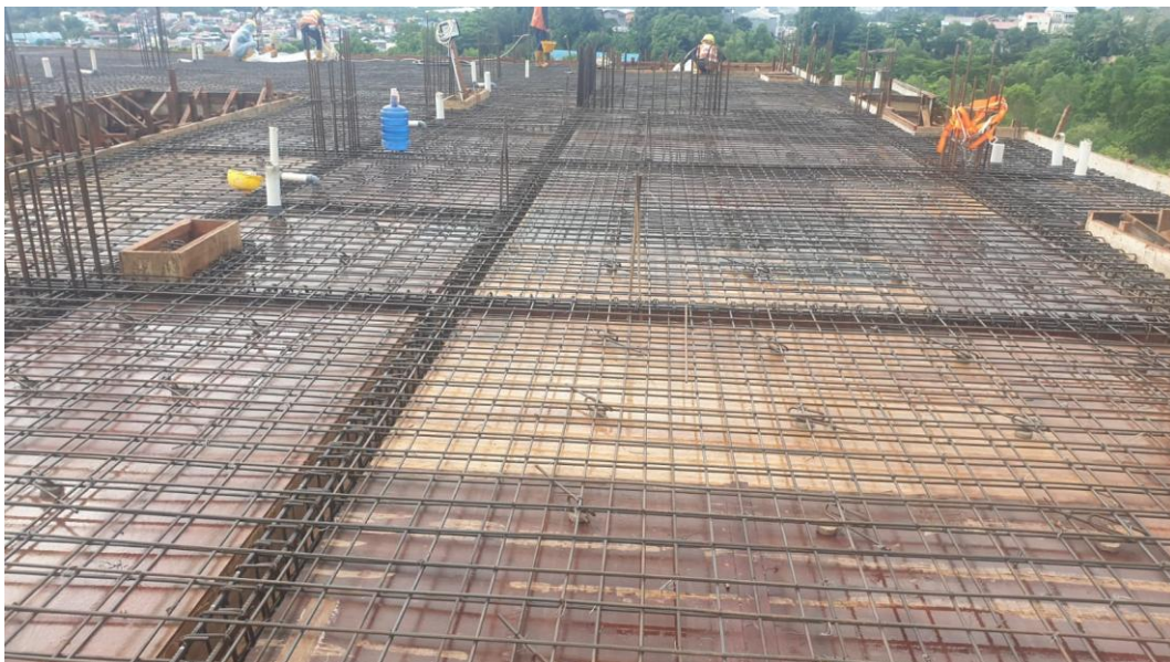
Lampiran L-7.2 Pemasangan Pembesian pada Pelat Lantai
