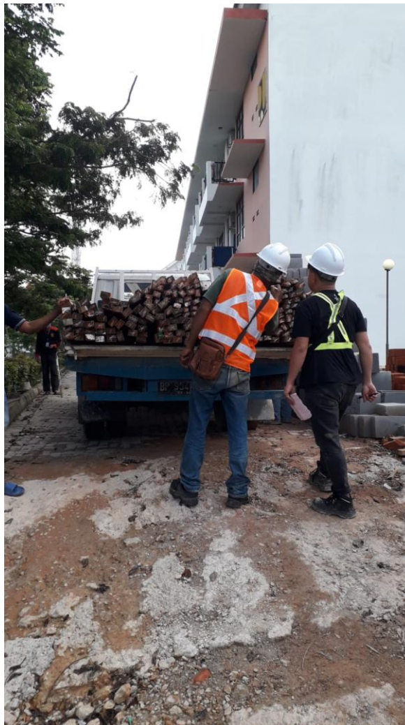
Lampiran L-1.4 Pengangkutan Material Kayu ke Lokasi Proyek
