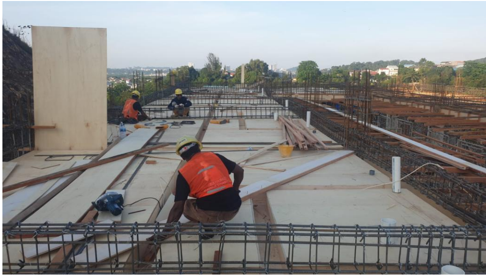
Lampiran L-3.3 Pembuatan Bekisting Pelat Lantai
