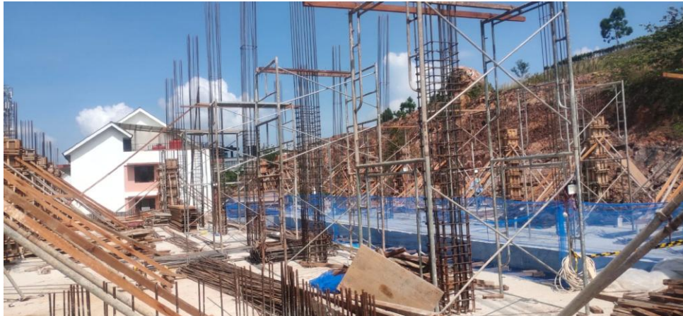
Gambar 4.10 Pekerjaan Pembesian Kolom
