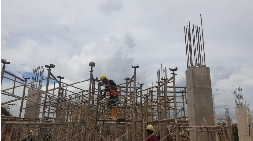
Lampiran L-5.1 Pemasangan Scaffolding
