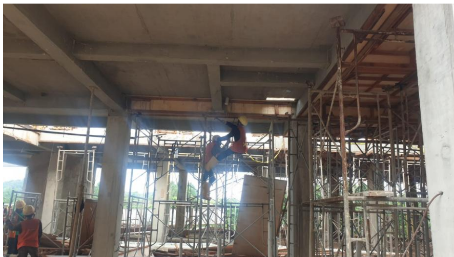
Gambar 5.27 Pekerjaan Pelepasan Bekisting
