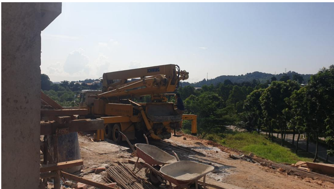
Lampiran L-8.4 Pump Concrete Memasuki Lokasi Proyek
