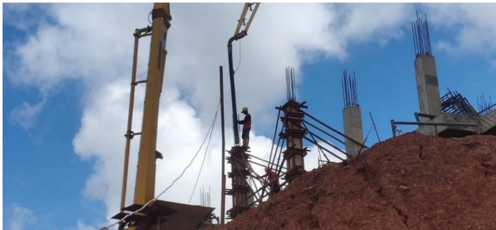
Gambar 4.2 Pekerjaan Pengecoran Kolom
