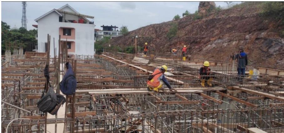
Gambar 4.8 Pekerjaan Pembesian
