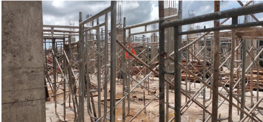
Gambar 4.7 Pekerjaan Pemasangan Scaffolding
