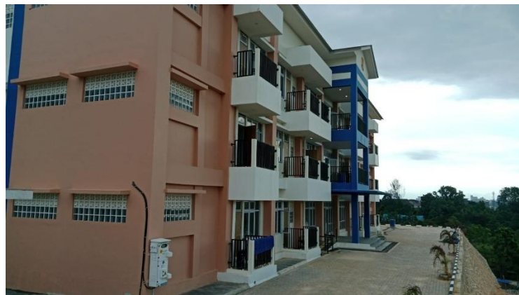
Gambar 1.1 Proyek Pembangunan Rusun ITEBA
