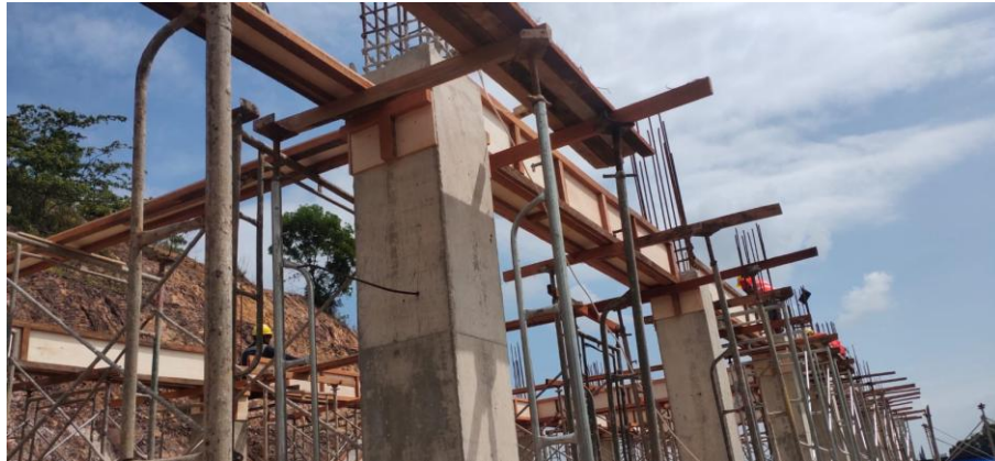
Lampiran L-6.1 Pemasangan Bekisting Balok
