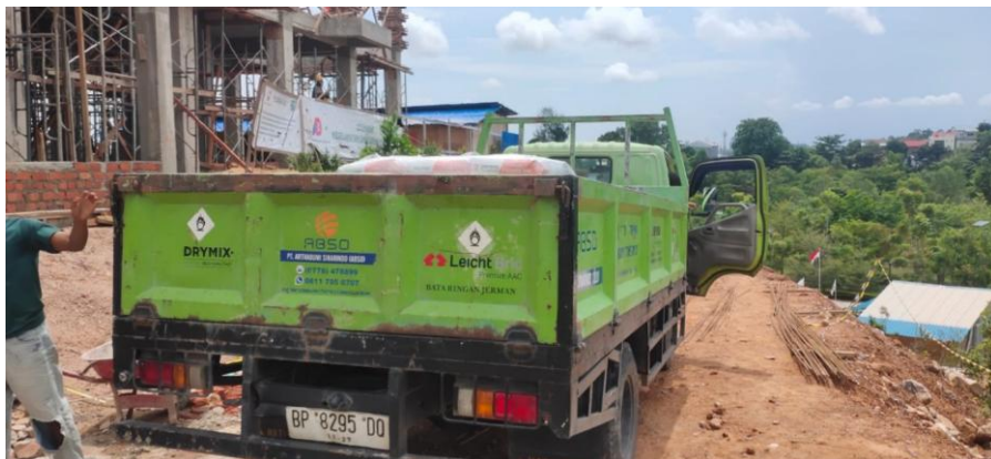
Gambar 4.9 Pekerjaan Mobilisasi Material ke Lokasi Proyek
