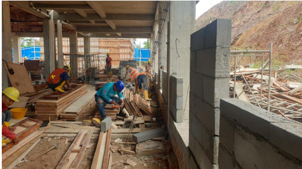
Lampiran L-3.1 Pembuatan Bekiting Kolom
