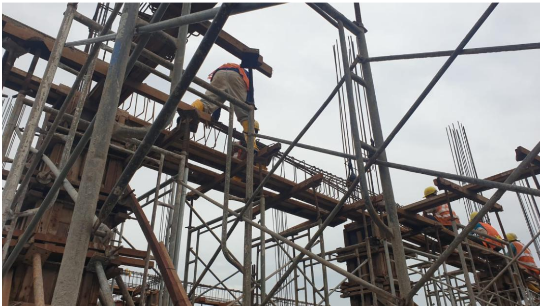
Lampiran L-7.3 Pemasangan Pembesian Balok
