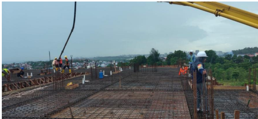
Gambar 5.30 Pekerjaan Pengecoran Struktur Atas
