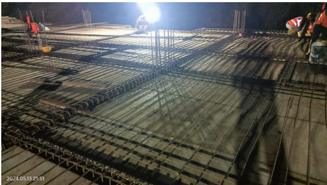
Lampiran L-7.4 Pemasangan Pembesian Pelat Lantai saat Malam Hari
