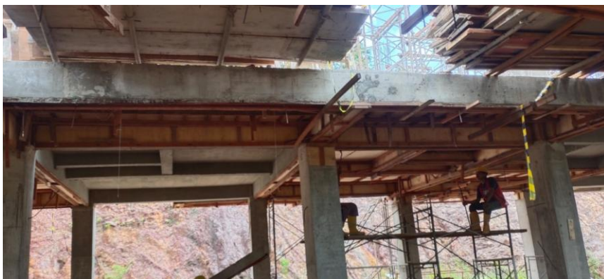
Gambar 4.6 Pekerjaan Pelepasan Bekisting
