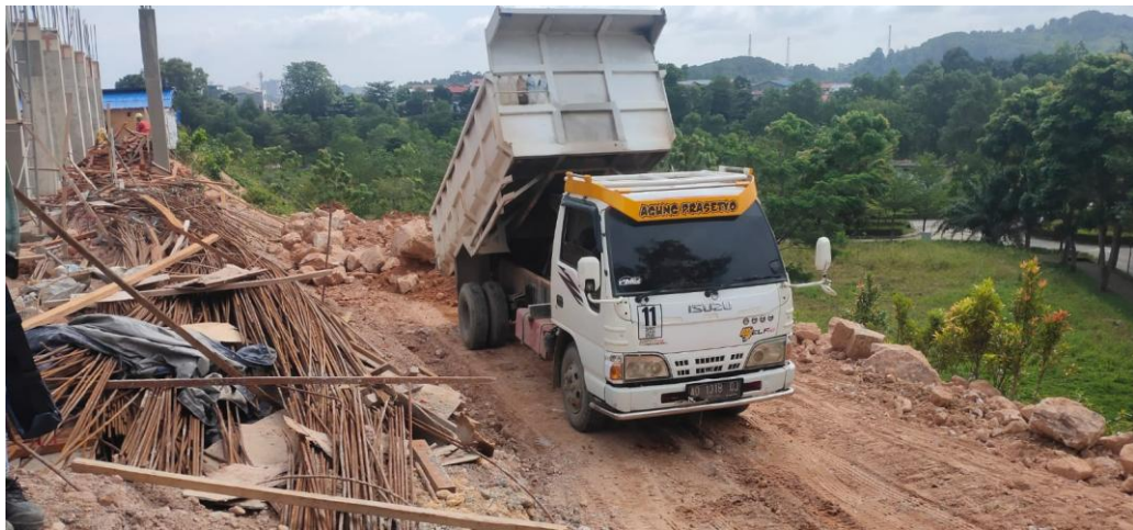
Gambar 5.15 Pekerjaan Penimbunan Tanah pada Jalur Mobilisasi
