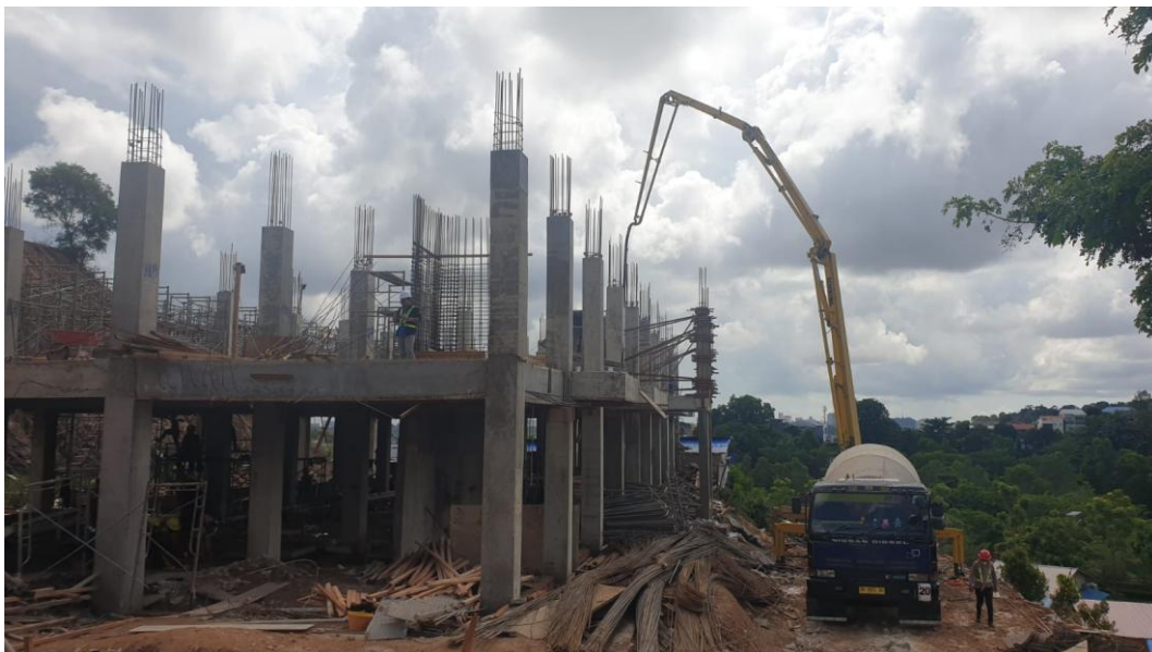
Lampiran L-8.2 Kendaraan Berat Pengecoran di dalam Lokasi Proyek
