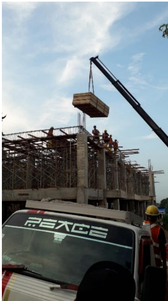
Lampiran L-2.2 Pengangkutan Material Papan Bekisting ke Lantai Atas
