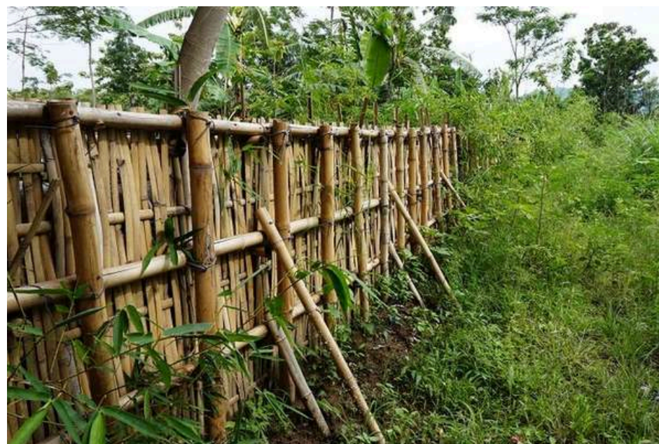
Contoh bambu untuk menahan tanah agar tidak longsor
