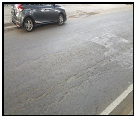
Gambar 4.6. Kerusakan Alur Gambar 4.7. Kerusakan Lubang
