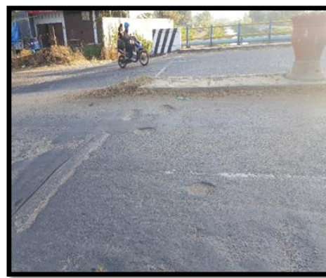
Gambar 4.8. Kerusakan Alur Gambar 4.9. Kerusakan Lubang Retak dan Kulit Buaya
