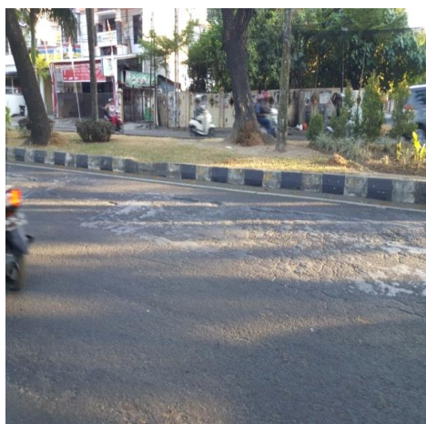
Gambar 4.4. Kerusakan Pelepasan
