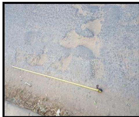
Gambar 4.6. Kerusakan Alur Gambar 4.7. Kerusakan Lubang
