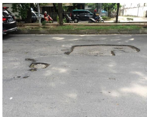
Gambar 4.10. Kerusakan Kegemukan Gambar 4.11. Kerusakan Pathole
