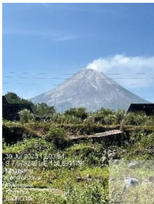
Gambar 5 Keruntuhan Subdam BE-RD1A
