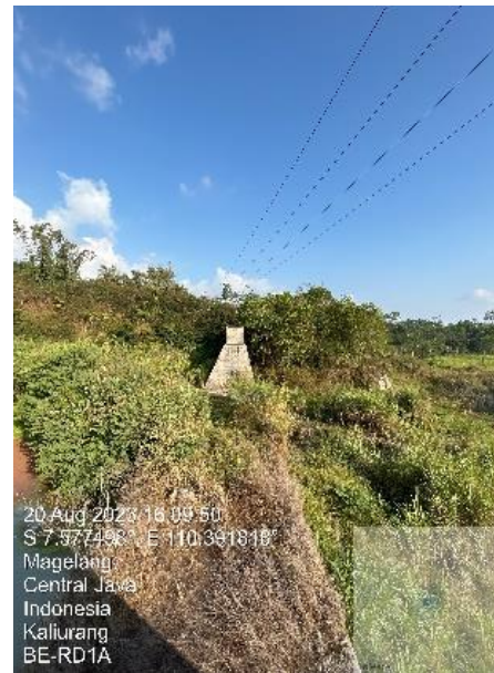
Gambar 4. Penumpukan Sedimen dan Vegetasi di Pelimpah
