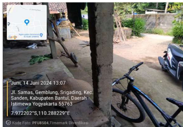
Gambar 15. Struktur Kolom Keropos
