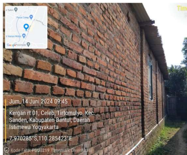
Gambar 18. Tampak Luar Bangunan Rumah Tanpa Tulangan
