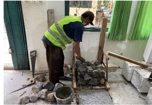
Gambar 2. Pemasangan fondasi dengan blok beton
