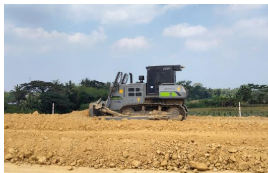
Gambar 1 Pelaksanaan Pekerjaan Timbunan
