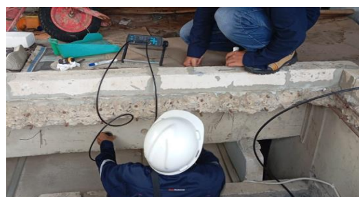
Gambar 12. Pelaksanaan uji non-destruktif ultrasonic pulse velocity
