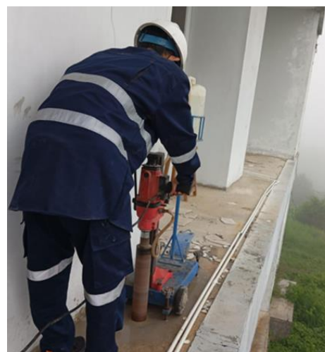
Gambar 15. Proses pengambilan sampel beton inti ( core drill ) pada elemen struktur pelat
