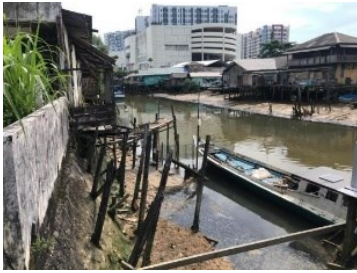
Gambar 10 Kondisi Lapangan Penampang T7
