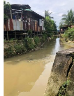
Gambar 6 Kondisi Lapangan Penampang T3
