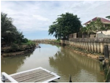
Gambar 11 Kondisi Lapangan Penampang Hilir
