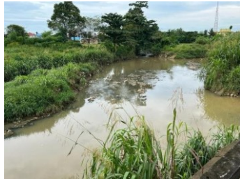
Gambar 3 Kondisi Lapangan Penampang Hulu
