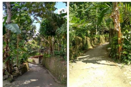
Gambar 15. Situasi Medan Jalan yang Cukup Sempit dan Curam
