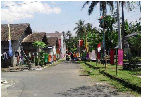
Gambar 3. Jaringan Jalan Sudah Terlihat Baik (Aspal)
