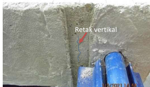
Gambar 13. Retak geser vertikal pada tumpuan
