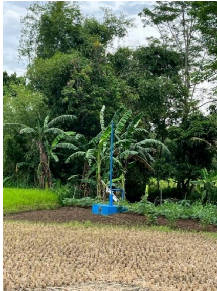
Gambar 4. 9 Sumber air (sumur) yang digunakan oleh PAMSIMAS Banyu Panguripan
