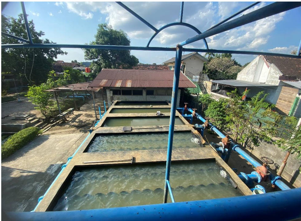
Gambar 4. 4 Unit Filtrasi
