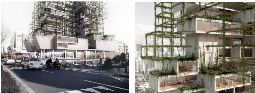
Gambar 2.27 Penerapan Konsep Green pada Fasad Bangunan Jordan Tower
