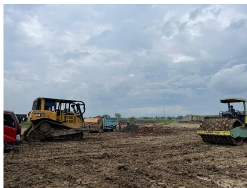
Gambar 5. 1 Pekerjaan Timbunan
