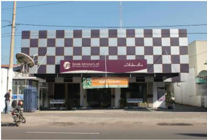
Gambar 12.3. Gedung Kantor Cabang Pembantu Lemabang Sumber : Data Sekunder, Foto 2017
