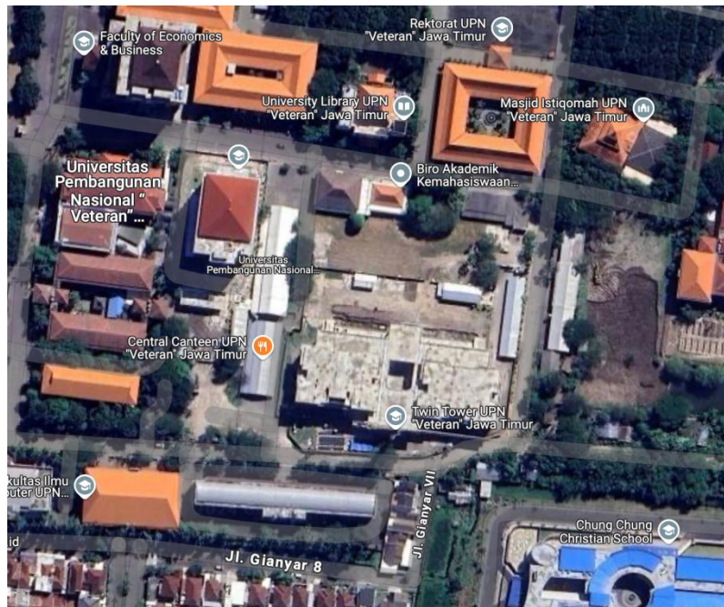
Gambar 5. 18 Lokasi Pengecoran Beton Ready Mix
