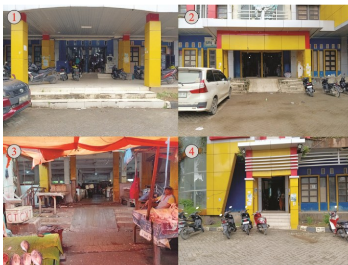
Gambar 25 Kondisi jalur masuk bangunan Pasar Sentral Kota Kendari Sumber: Dokumen Pribadi, 2024
