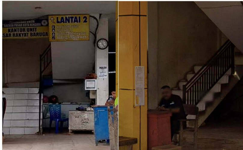
Gambar 91 Kondisi tangga pada Pasar Baruga Sumber: Dokumen Pribadi, 2024
