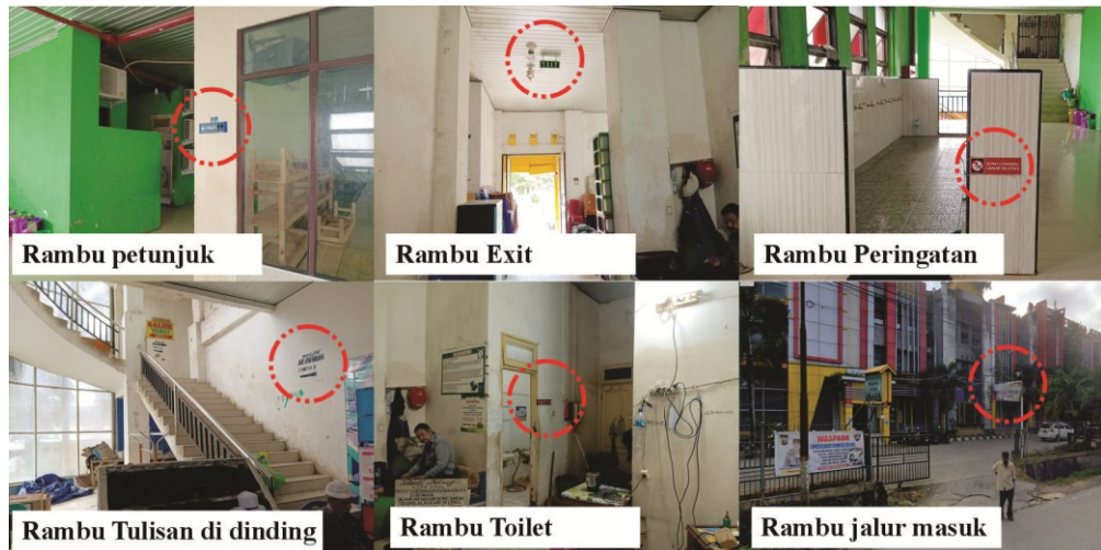
Gambar 53 Kondisi rambu pada Pasar Sentral Kota Kendari Sumber: Dokumen Pribadi, 2024
