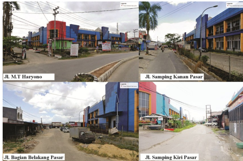
Gambar 18 Kondisi Pasar Sentral Wua-wua Sumber: Penulis, 2024
