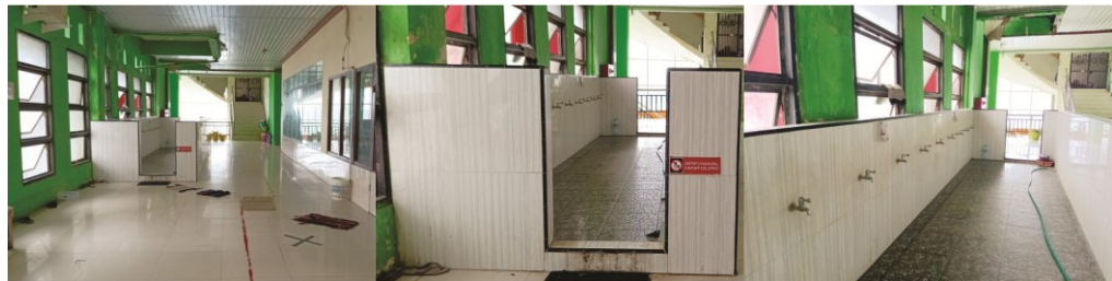
Gambar 51 Kondisi tempat wudhu Sumber: Dokumen Pribadi, 2024
