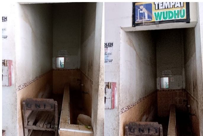
Gambar 99 Kondisi tempat wudhu Pasar Baruga Sumber: Dokumen Pribadi, 2024
