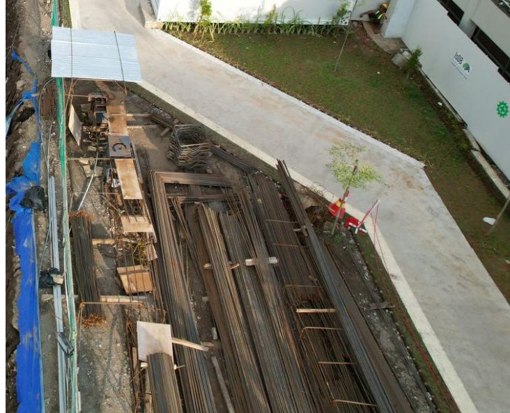
Gambar L-1.1 Workshop Fabrikasi Besi Tulangan
