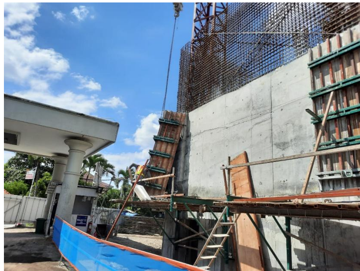
Gambar L-1.5 Pekerjaan Pembongkaran Bekisting Shear Wall
