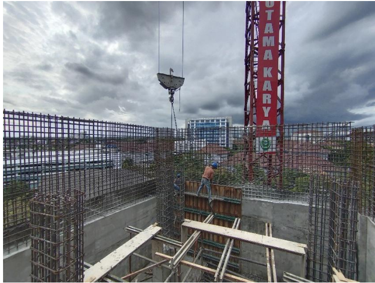
Gambar L-1.3 Pekerjaan Install Bekisting Shear Wall
