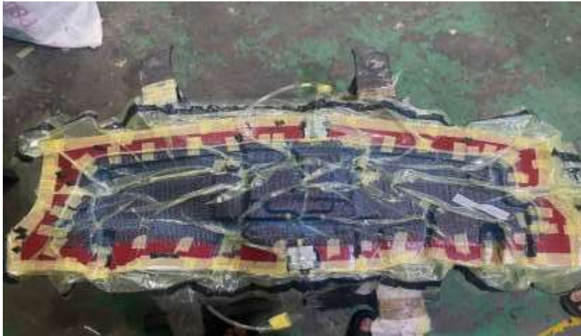
Gambar 3.4-4 Pemasangan Vacuum Bagging
