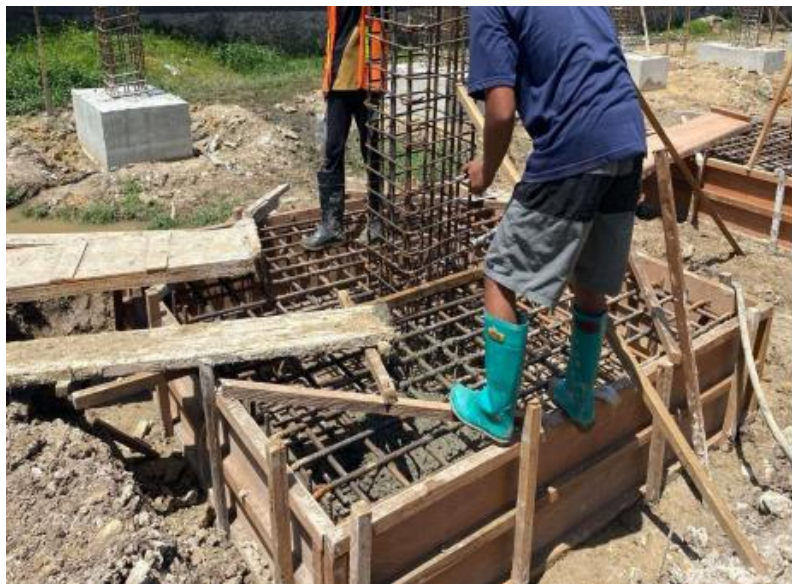
Gambar L - 1. 2 Pengecoran Pile Cap
