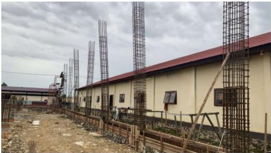
Gambar L - 1. 4 Pembesian Kolom
