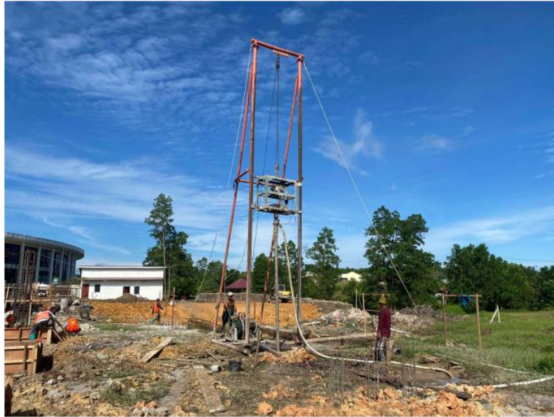
Gambar L - 1. 1 Proses pengeboran Borepile
