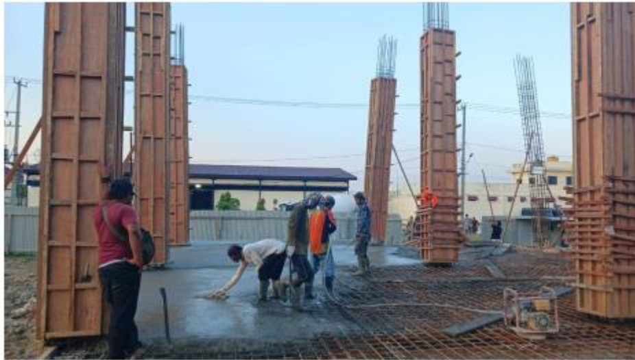
Gambar L - 1. 5 Pengecoran Plat Lantai 1
