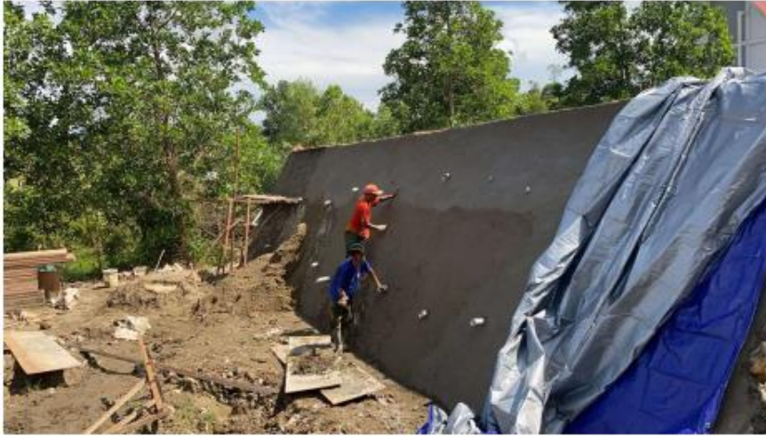
Gambar L - 1. 3 Pekerjaan Dinding Penahan Tanah
