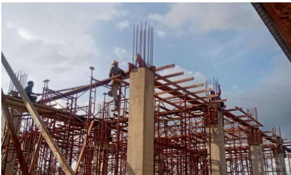
Gambar L - 1. 6 Pekerjaan Balok Dan Pelat Lantai 2
