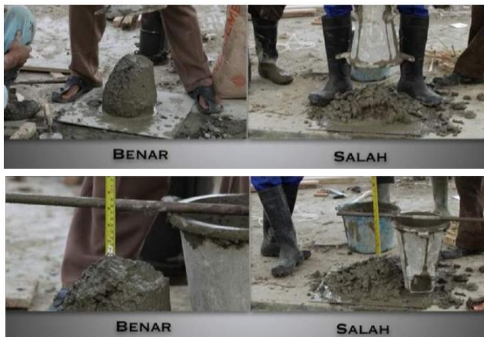
Gambar 3. 7 Pengujian Hasil pencampuran beton dengan cetakan atau uji slump
