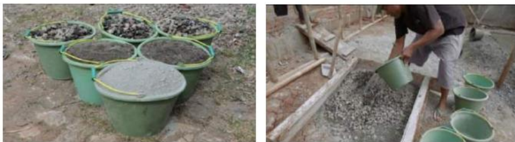
Gambar 3. 5 Komposisi Campuran Beton dan Proses Pencampuran Beton
