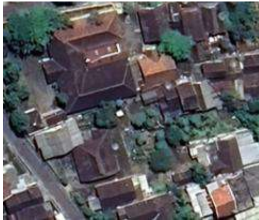
Gambar 4.84 Tampak visual atap bangunan
