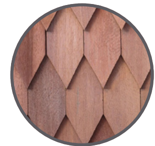
Material atap menggunakan atap Sirap.
