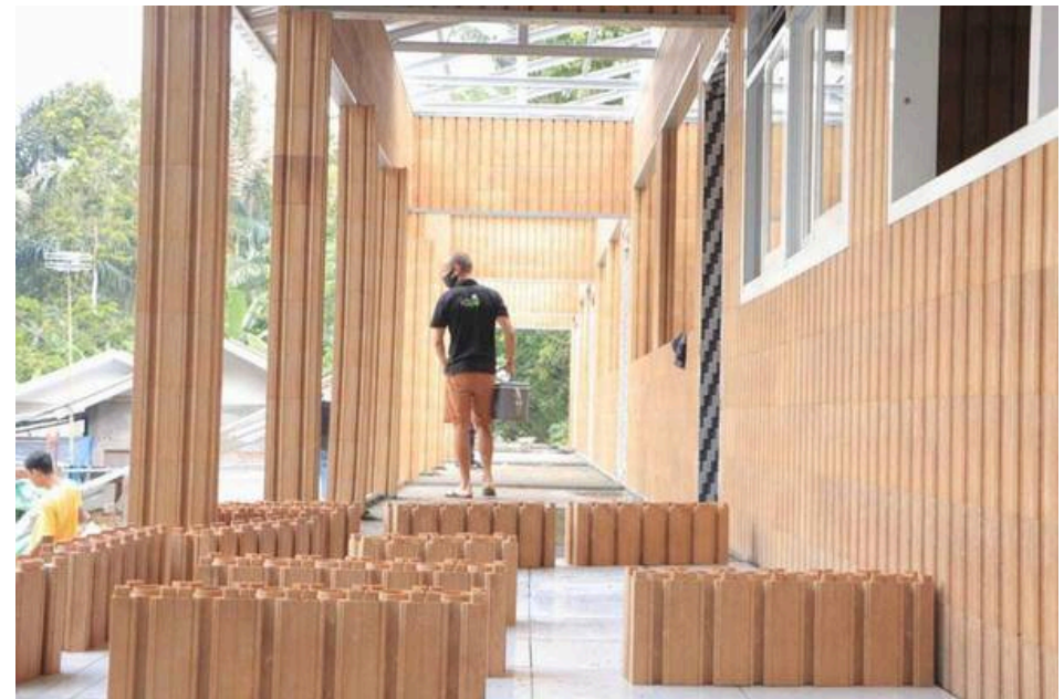
Gambar 2.4.5. Foto pembangunan dinding ecobrick Sumber : Kompas.com, 2021
