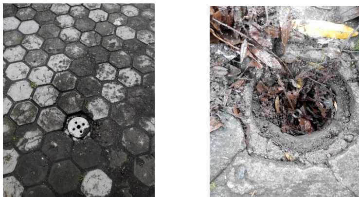
Gambar 5.14 Kondisi LRB yang diberi Sampah Organik di Dusun Kimpulan
