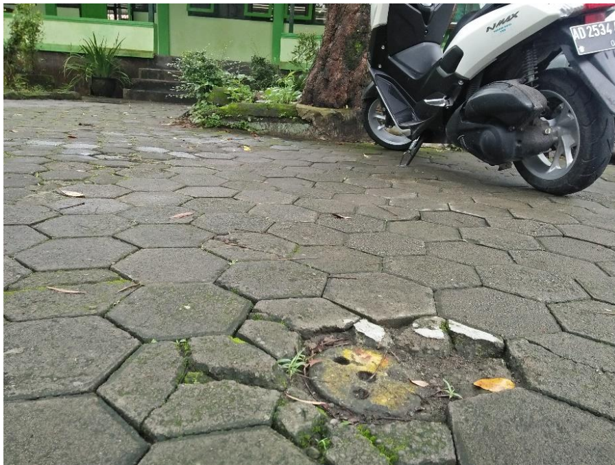
Gambar 5.8 Lubang Resapan Biopori di SMK Bina Harapan
