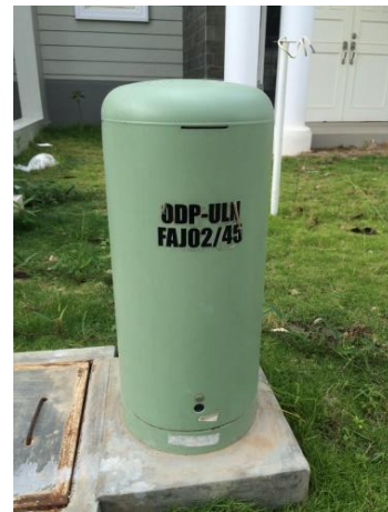
Gambar 2. 4 ODP Pedestal
