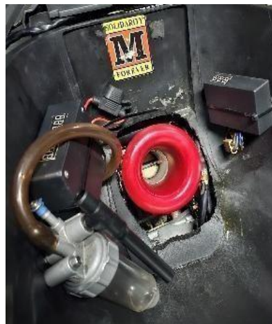
Gambar 4-13 Hasil pemasangan corong
