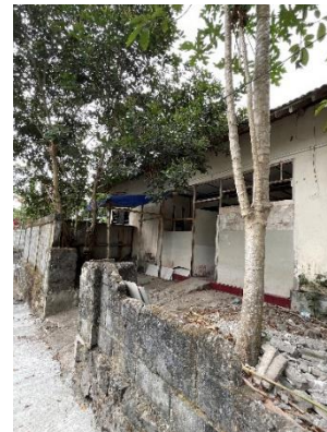
Gambar 5. Tampak depan bangunan
