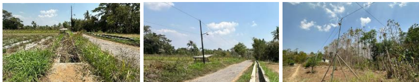
Gambar 2. Gambar Infrastruktur Penerangan Jalan Umum (PJU) Dusun Wonosalam Sumber : Dokumen Pribadi
