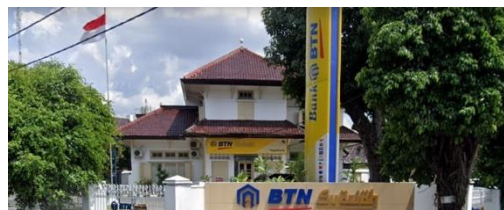
Gambar 3 Bangunan Bank BTN
