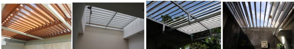
Gambar 23. Void atap solusi dari ketepatan desain void vertikal Sumber: (SunLouvre Adjustable Sun Shading, n.d.)
