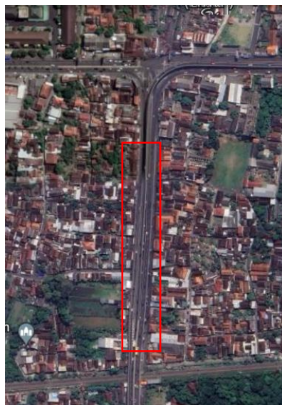
Gambar 1 1 Jembatan Layang Janti Sumber: Google earth tahun 2023
