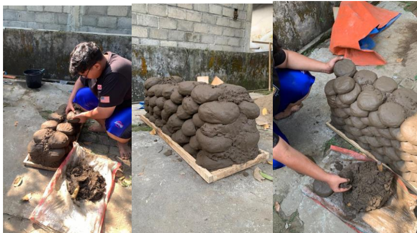
Gambar 7. Penyusunan Dinding Polpolan Sumber: Dokumentasi Penulis, 2023
