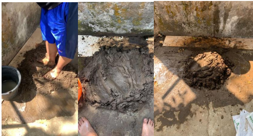
Gambar 5. Adonan Dinding Polpolan Sumber: Dokumentasi Penulis, 2023
